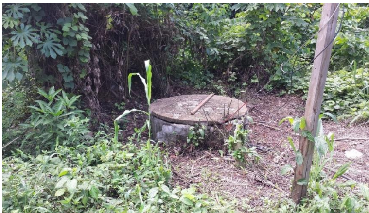
FIGURA 46 – POÇO PROFUNDO SEM QUALQUER ISOLAMENTO EM MEDICILÂNDIA. (FONTE: AUTOR, 2016)
