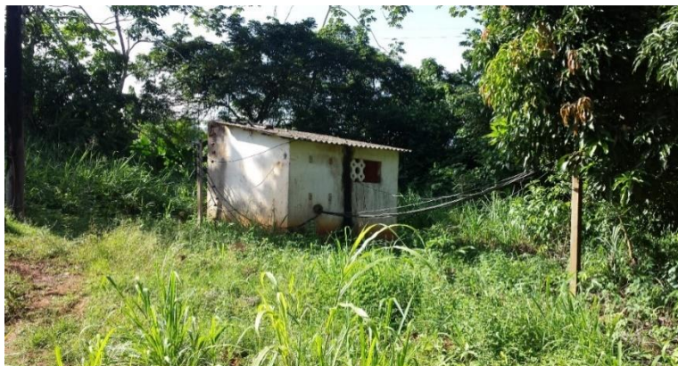
FIGURA 43 – CASA DE BOMBAS DE ESTAÇÃO ELEVATÓRIA (FONTE: Foto do auto 2016)
