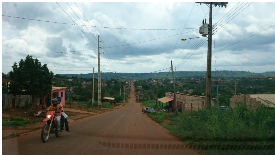
FIGURAS 58 – RUAS SEM ESTRUTURA DE DRENAGEM
