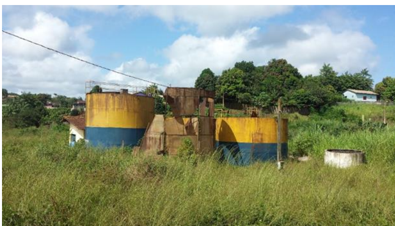
FIGURA 53 – ETE ABANDONADA, SOFREU INCENDIO.
