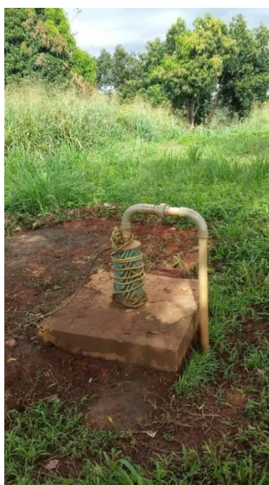
FIGURAS 47 e 48 – POÇO TUBULAR SEM QUALQUER ISOLAMENTO (FONTE: AUTOR, 2016)
