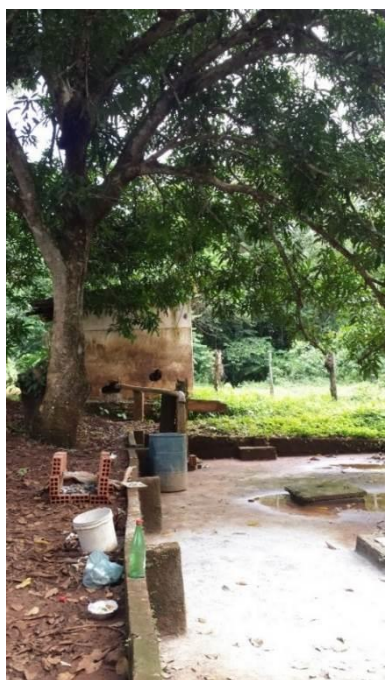
FIGURAS 47 e 48 – POÇO TUBULAR SEM QUALQUER ISOLAMENTO (FONTE: AUTOR, 2016)
